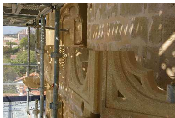
Remplacements des mains courantes du clocher
